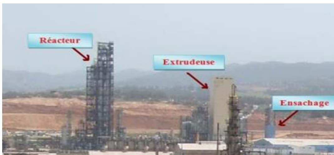
Figure II.3 : photo représente les principales installations de l'unité CP2K.
