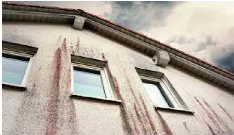
Figure 1.8. Coulée noire correspondant à l'écoulement de l'eau de pluie ( https://www.techni-murs.com/nos-activites/ravalement/ consulté le 29/06/2022)
