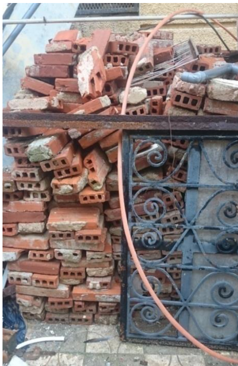
Figure 3.7. Débris de briques du théâtre régional de Skikda.
