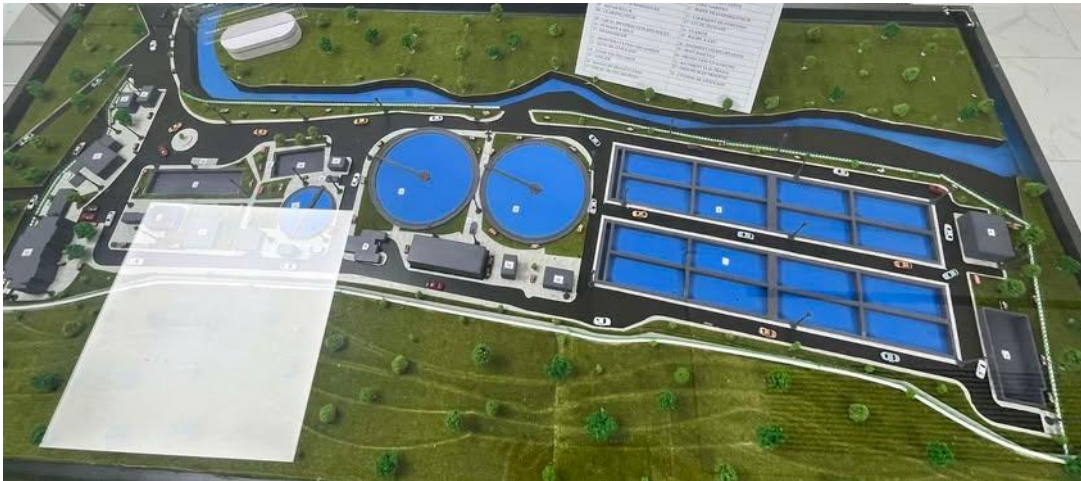
Figure.II.4 : Vue générale de la station d'épuration de Filfila
