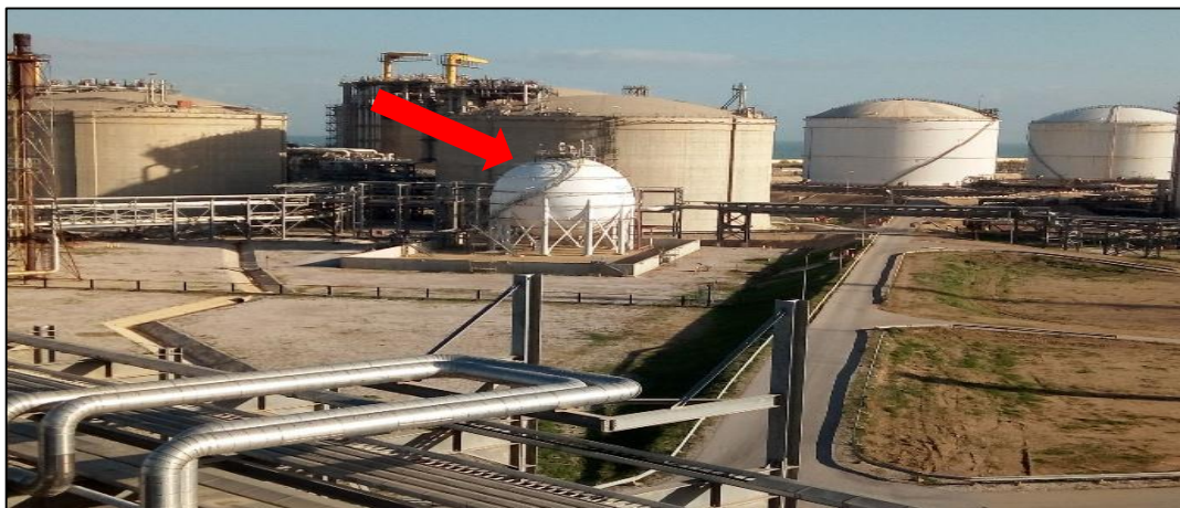
Figure 3.16 : Sphère de stockage de Gazoline 76-MD-03 [80]
