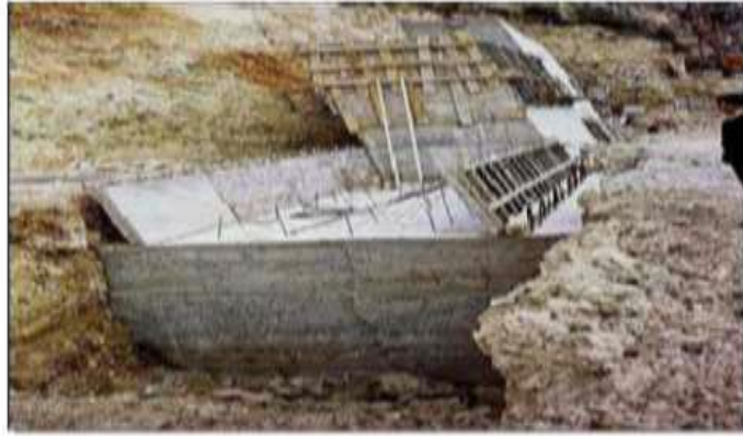
Figure 4.12 : Exemple d'ouvrage rigide : Mur en béton armé (Service d'Etude Technique des Routes et Autoroutes.
