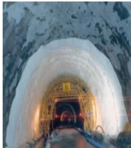
Figure 2.24 : Etanchéité d'un tunnel
