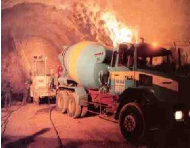
Figure2.14 : photo de Mise en place de béton projeté
