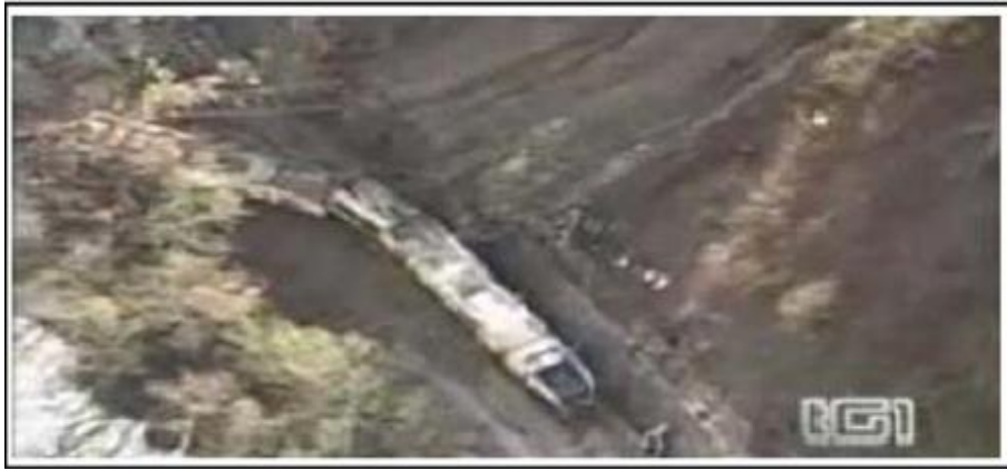
Figure 1.15: Glissement de terrain causé par une explosion (Italie)
