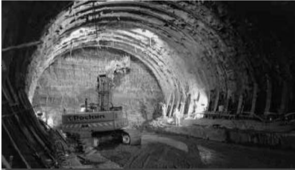
Figure 2.4: Creusement en pleine section[13].
