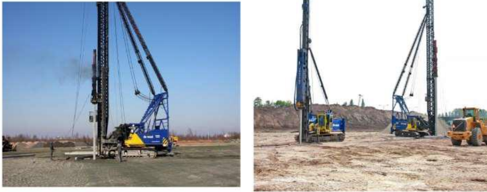
Figure 4.16 : Photos pendant la réalisation de pieux battus.
