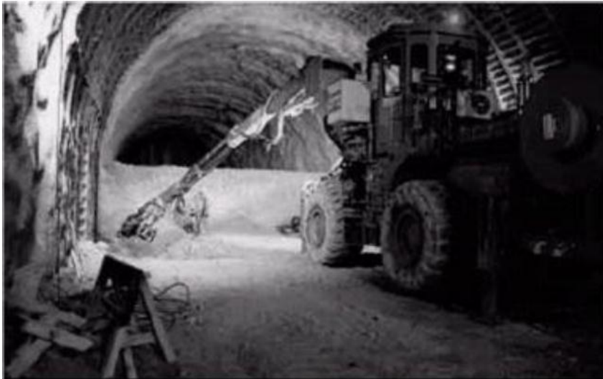
Figure 2.5: Creusement en demi-section [13].
