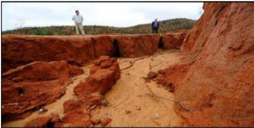
Figure 1.17: Glissement de terrain causé par la présence d'érosion
