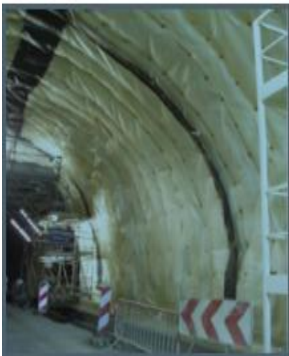
Figure 2.24 : Etanchéité d'un tunnel
