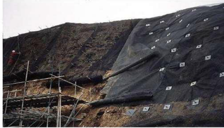
Figure 4.15 :Un versant stabilisé par clouage.
