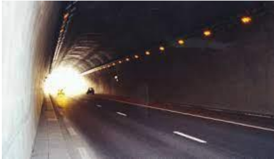
Figure 2.23 : Tunnel de Cornil (RN 89 - Corrèze) L'éclairage de renforcement d'entrée d'un sens joue le rôle de renforcement de sortie pour l'autre sens [23].
