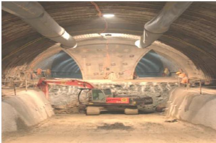
Figure 2.6: Creusement en section divisée [14].
