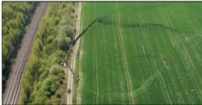
Figure 1.8: Affaissement de terrain
