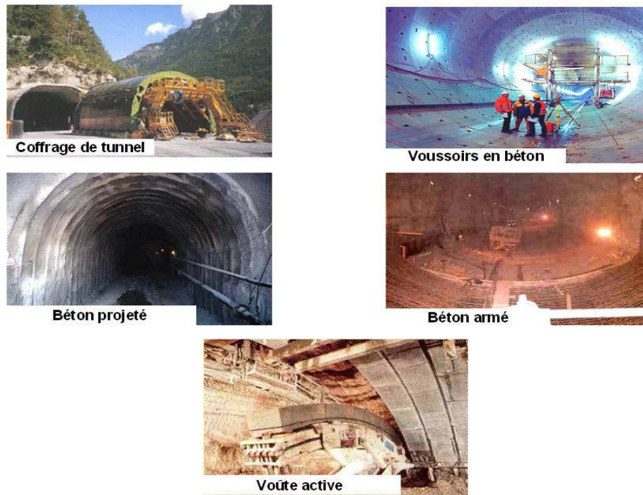
Figure 2.17: Différents types du soutènement, revêtement [20].
