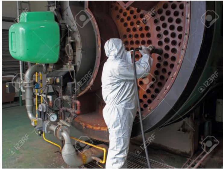
Figure II.5 : Chaudière à vapeur industrielle en cours de nettoyage hydraulique [17].
