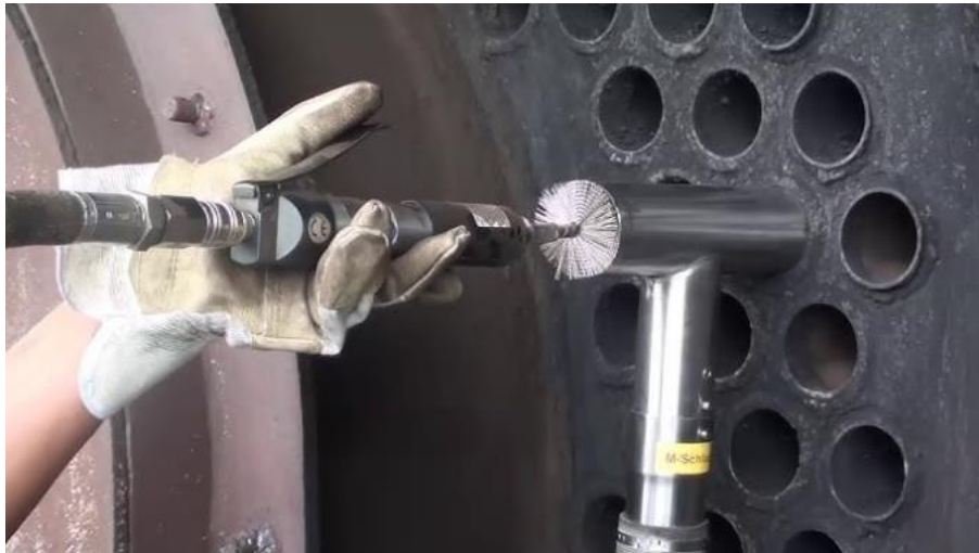
Figure II.6 : Nettoyage par launch de projectiles (racleurs/brosses) [17].
