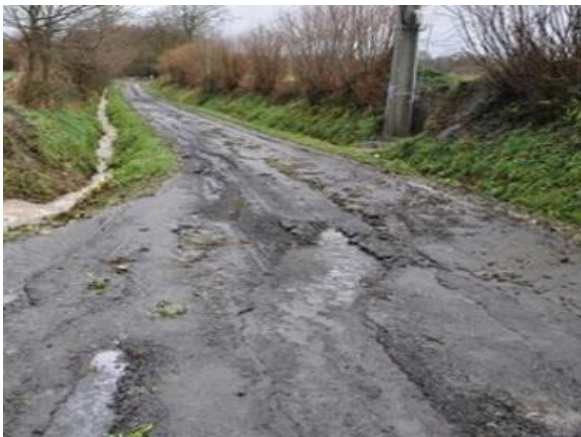
Figure IV.1 Affaissement et Glissement
