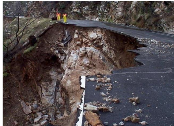
Figure IV.1 Affaissement et Glissement
