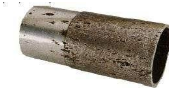
Figure. I.11. Corrosion par piqu re d'un l'acier inoxydable.
