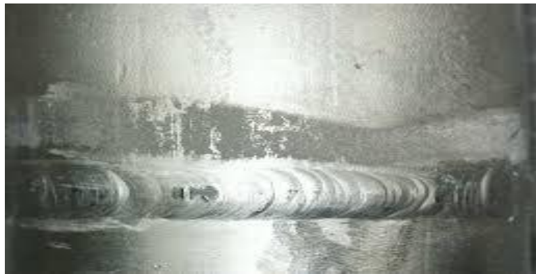
Figure. I.13. Corrosion sous contrainte d'un l'acier inoxydable.
