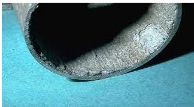
Figure. I.12. Corrosion intergranulaire d'un l'acier inoxydable.
