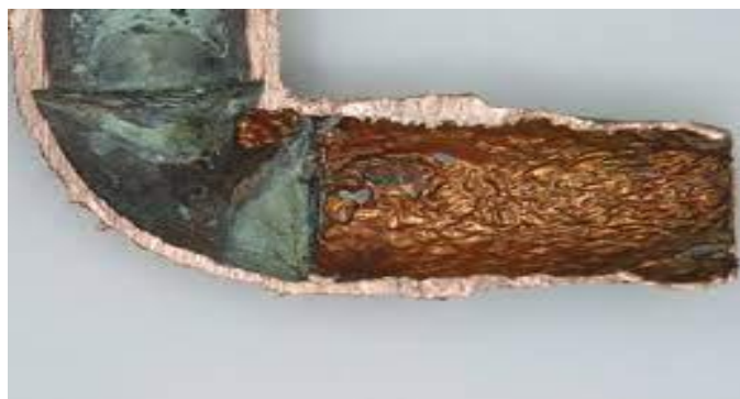
Figure. I.7. Corrosion par érosion.
