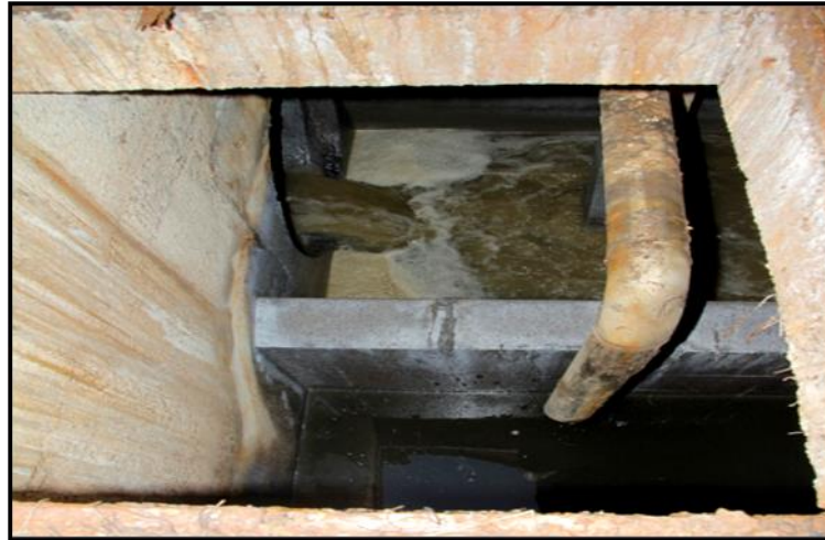
Figure II.3 : Poste de relevage
