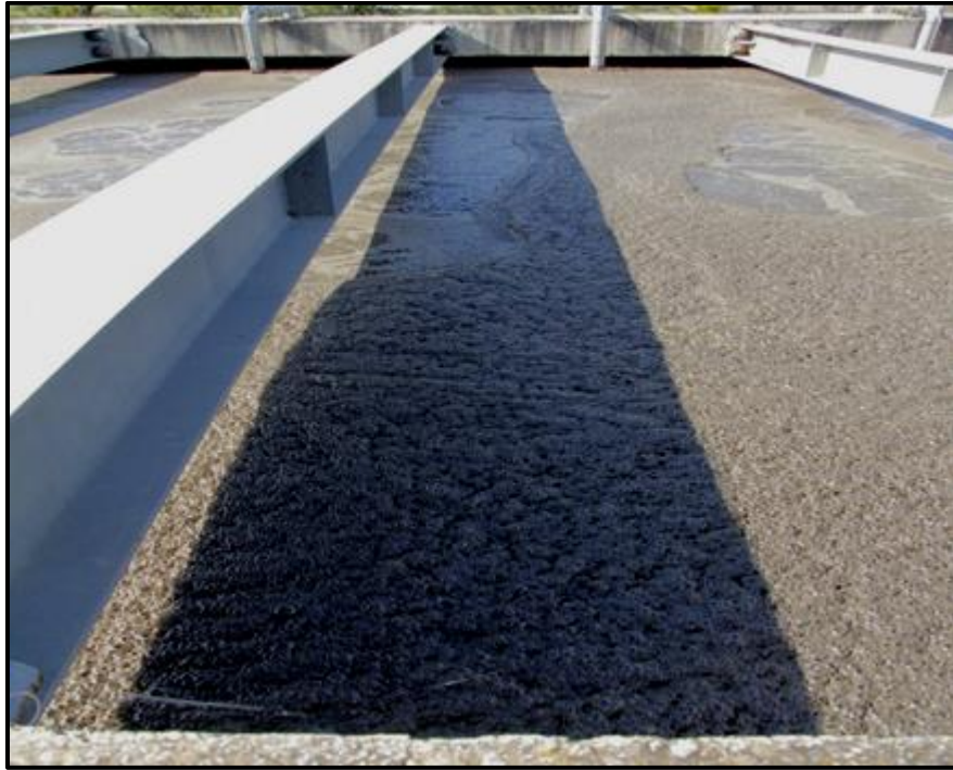
Figure II.13 : Zone aérée dans le chenal
