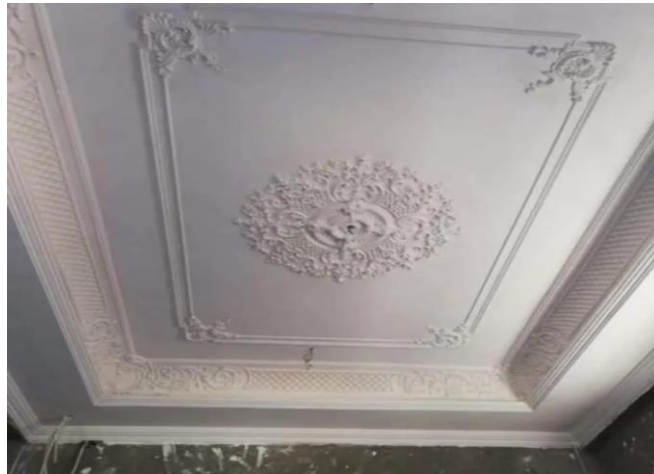
Image2-2 : plafond en plâtre
