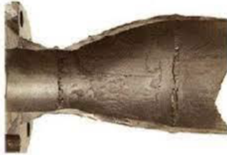
Figure I.9 : Corrosion-érosion dans une zone turbulente [16].
