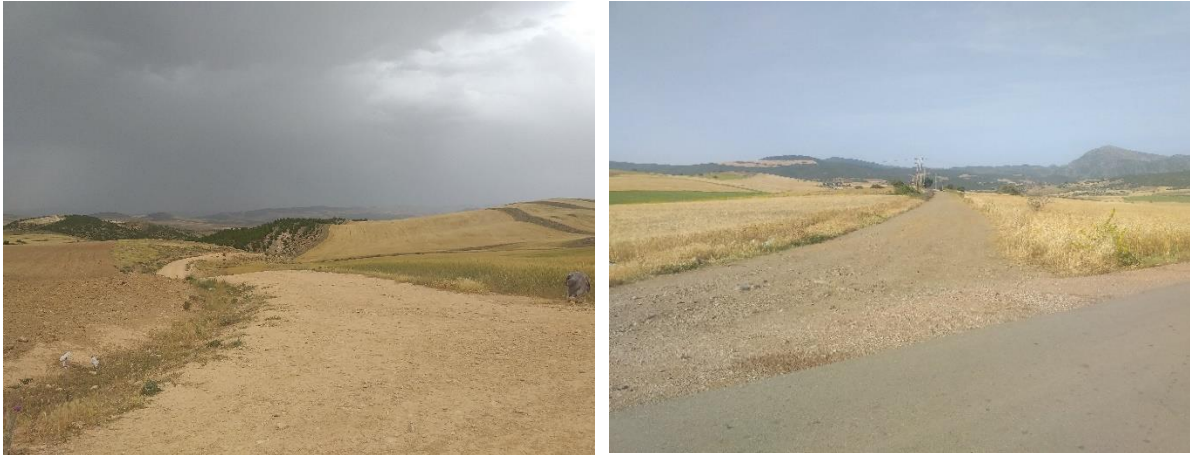
Piste dégradée_ Tamlouka
