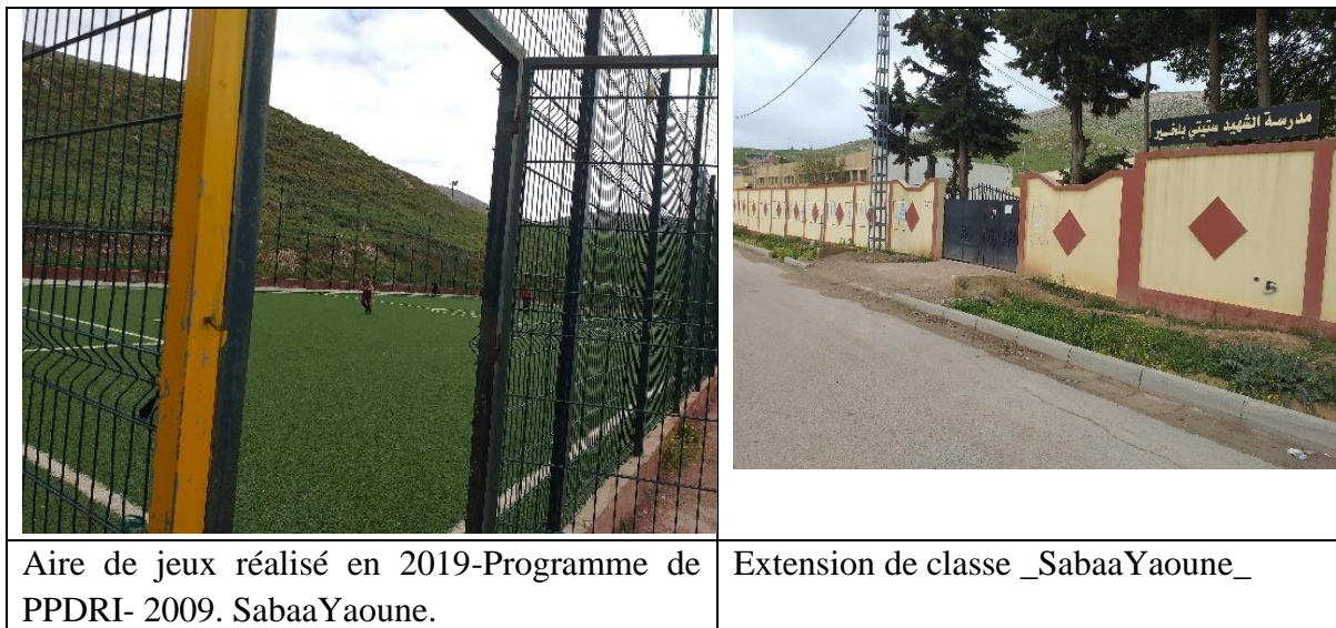
Figure 42. Equipements au niveau de la Commune de Ain Sandal.
