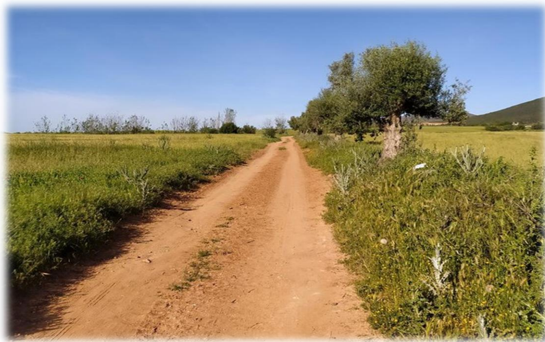
Photo 02 : l'aménagement des pistes
