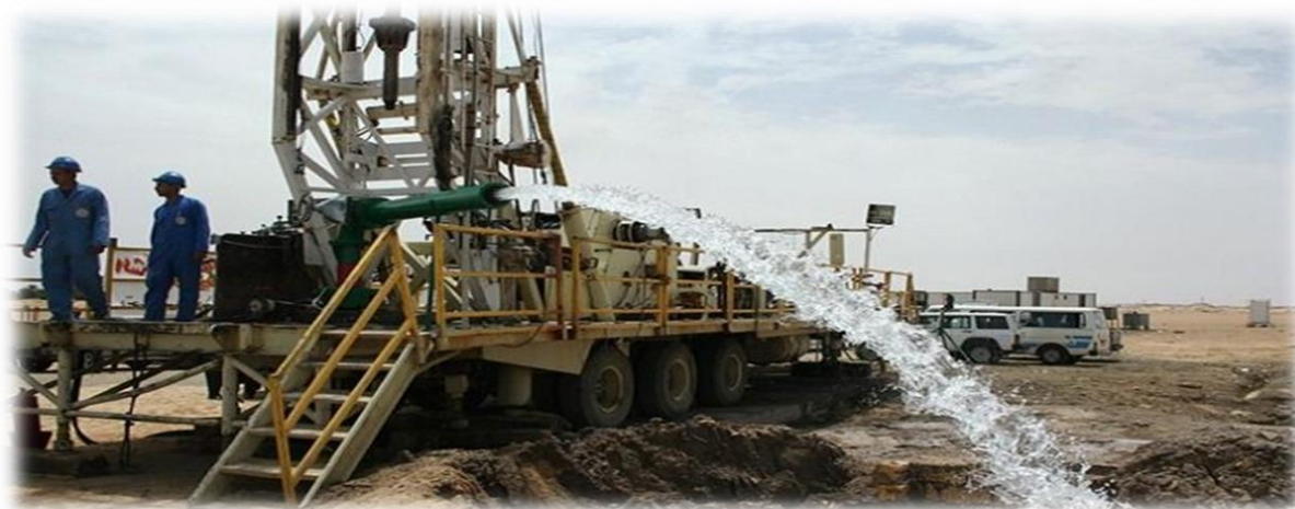
Photo 08: forage de puits d'eau
