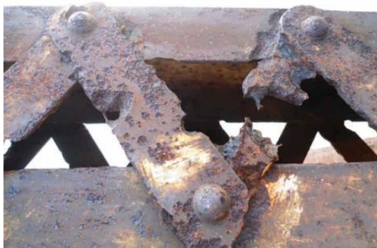
Figure I.8 : Corrosion par piqûre de l'aluminium.
