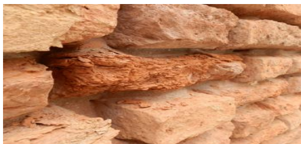
Figure 28: L'effritement des couches supérieures des briques cuites (Toolkit, 2021).
