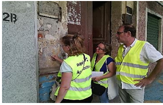
Figure 3 43: Le groupe AQUIDOS, lors d'une inspection sur site.
