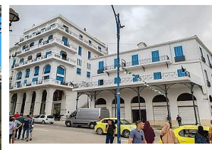
Figure 3 57: Façade après la réhabilitation.
