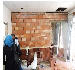
Figure 3 17: Utilisation de briques perforées pour remplir un mur de séparation.
