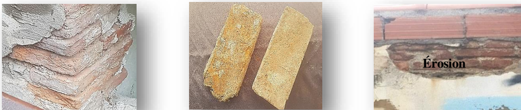
Figure 3 58: Les briques prélevées d'un mur de la terrasse de l'immeuble n.4, ilots 17, prise d'auteur, cliché auteur.
