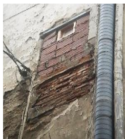
Figure 3 41: Utilisation de briques perforées pour remplir une partie de la paroi.
