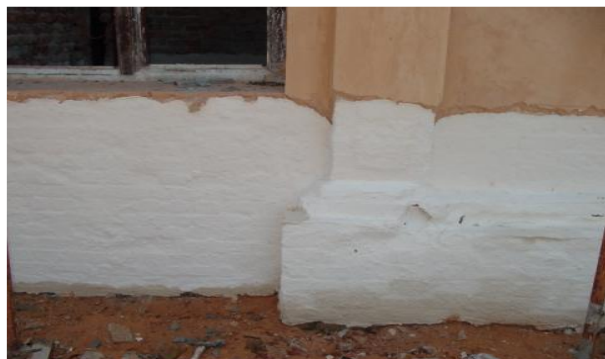
Figure 2 11: Le dessalement du sel sur les surfaces murales par le procédé de cataplasme (Ahmad & al, 2010).
