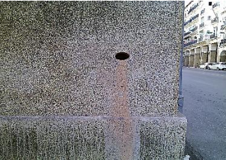
Figure 3 46: Prélèvement sur les colonnes des arcades.
