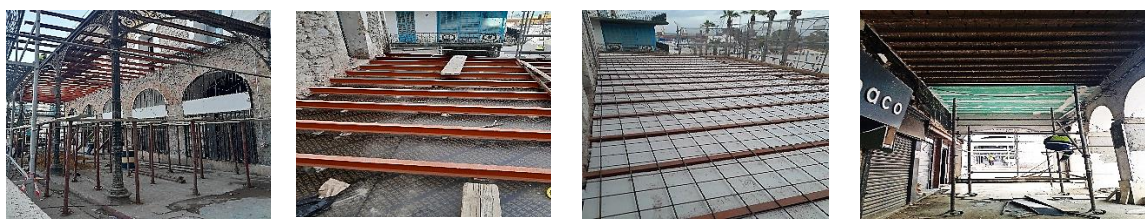
Figure 3 52: Les étapes de réhabilitation d'une terrasse.
