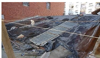
Figure 3 9: La charpente en tuile est entièrement démolie.
