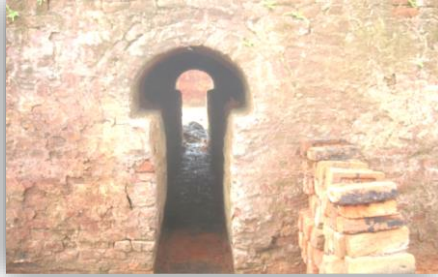
Figure 1 11: Chambre de cuisson pour la fabrication de briques, b) Four de la cuisson des briques cuites (Chanda, 2016; Akhtar & al, 2022).
