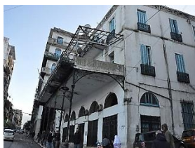
Figure 3 55: Façade avant la réhabilitation.
