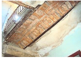
Figure 3 28: Déconstruction de la partie inférieure de la cage d'escalier.
