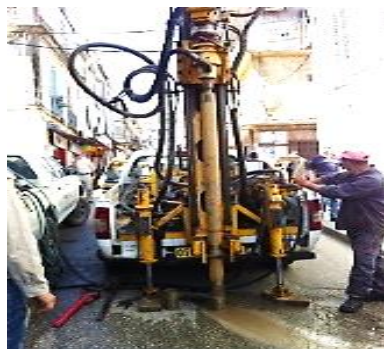
Figure 3 50: La réalisation des carottes.
