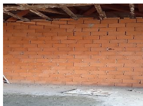
Figure 3 54: Reconstruction des murs en briques cuites perforées.
