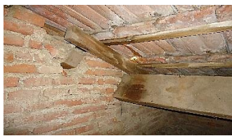
Figure 3 10: La charpente en tuile est entièrement démolie.
