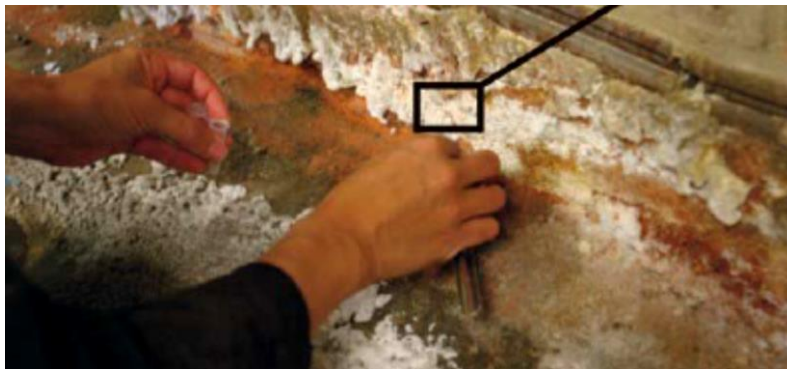
Figure 2 5: Des taches Subflorescence ou d'efflorescence en couleur blanche sur le mur (López-Arce & al, 2009).
