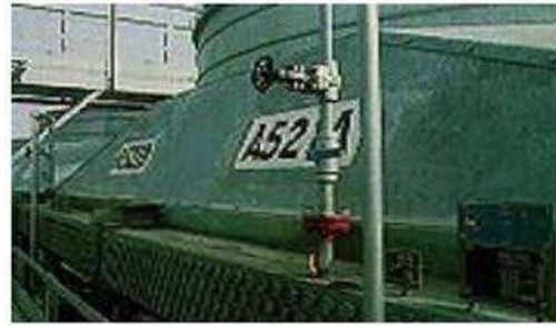
Figure II 10 Boite de distribution   bouchons d vissables
