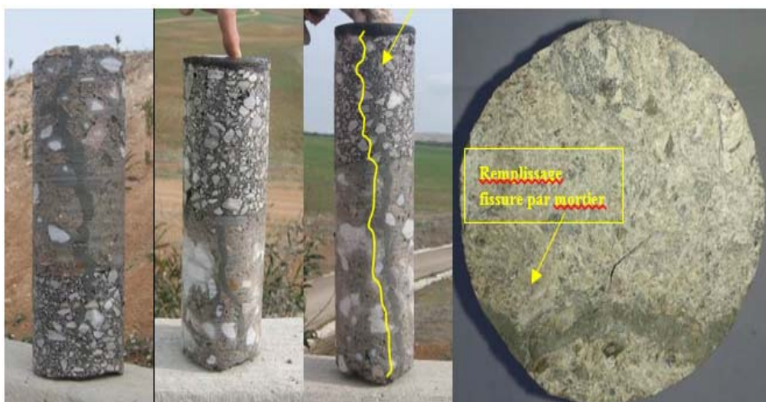
Figure V- 13: Carottage après injection
