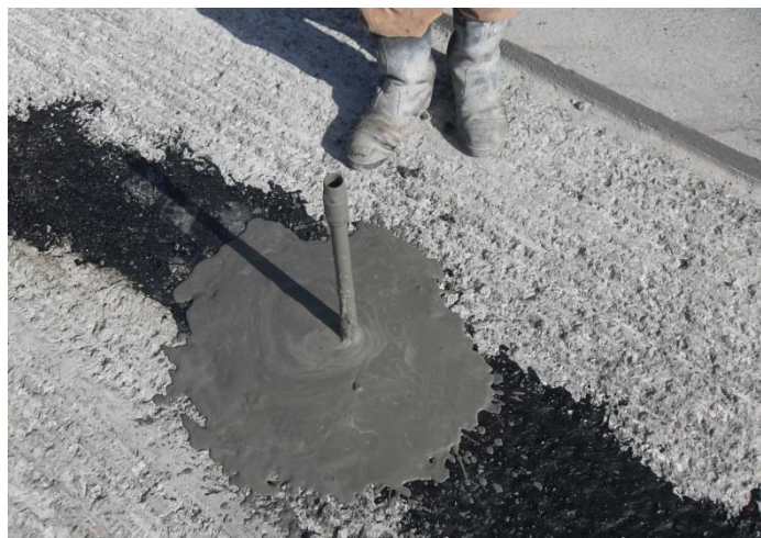
Figure V- 11: Le produit d'injection sort du prochain tube
