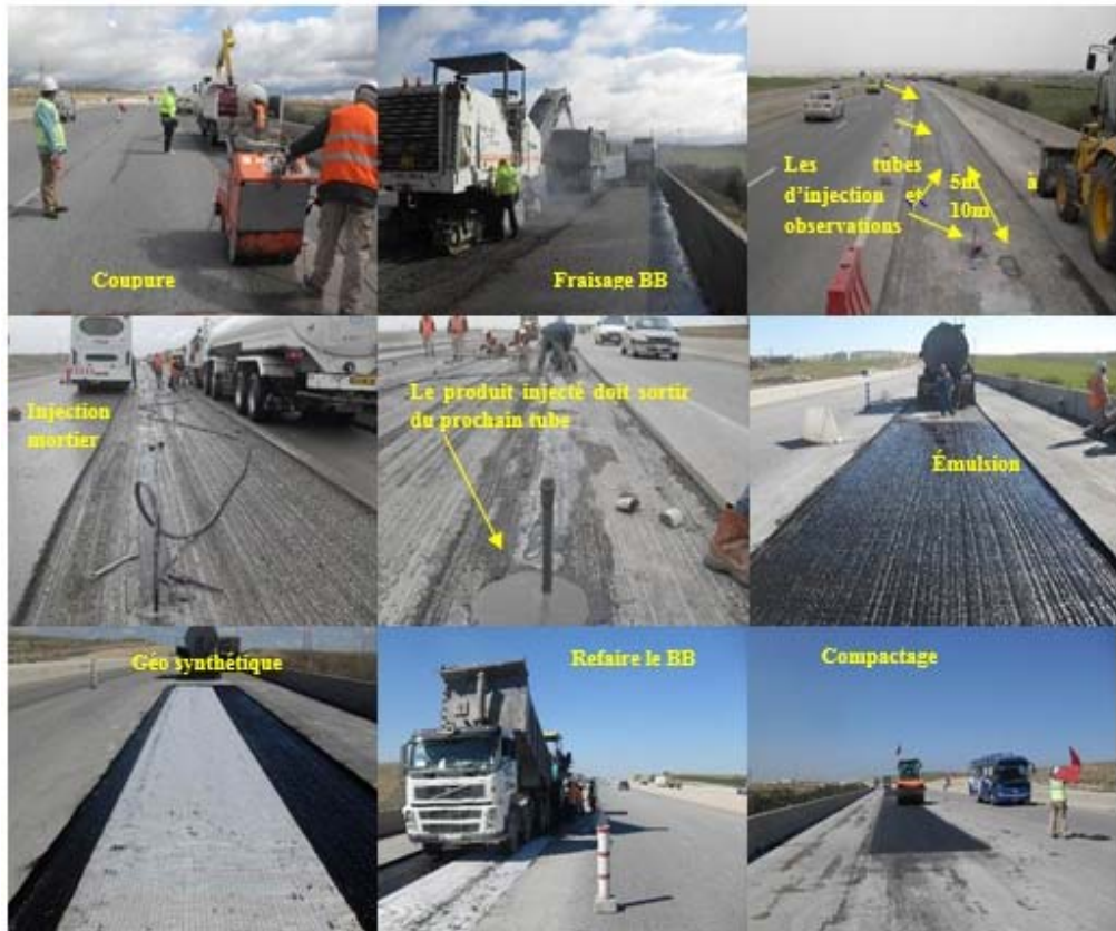
Figure V- 10: Réalisation sur site
