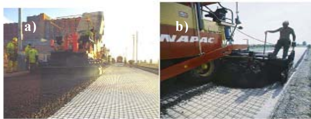
Figure I- 17: Mise en place de géo-grilles et treillis soudés pour prévenir la fissuration [FLO, 2005]
