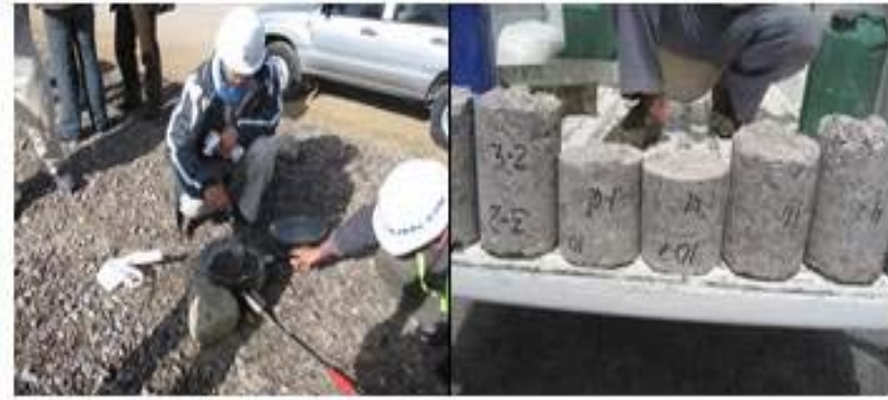
Figure III- 23: Travaux de contrôle supplémentaires
