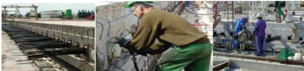
Figure V- 7: Travaux d'injection dans le cas de la précontrainte
