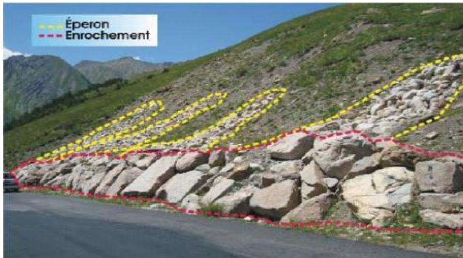
Figure 2.9: Stabilisation par enrochement.
