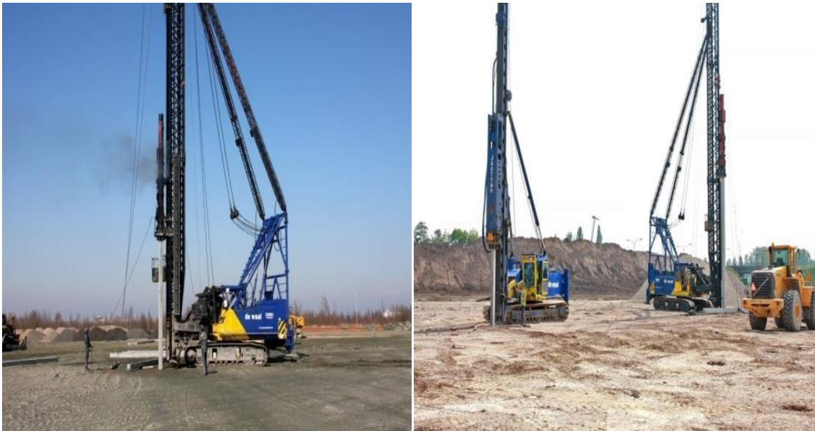
Figure 2.15 : Photos pendant la réalisation de pieux battus.
