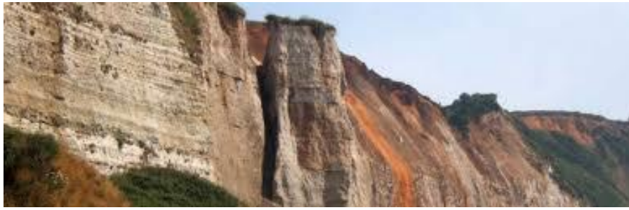
Figure 05: Éboulement ou écroulement
