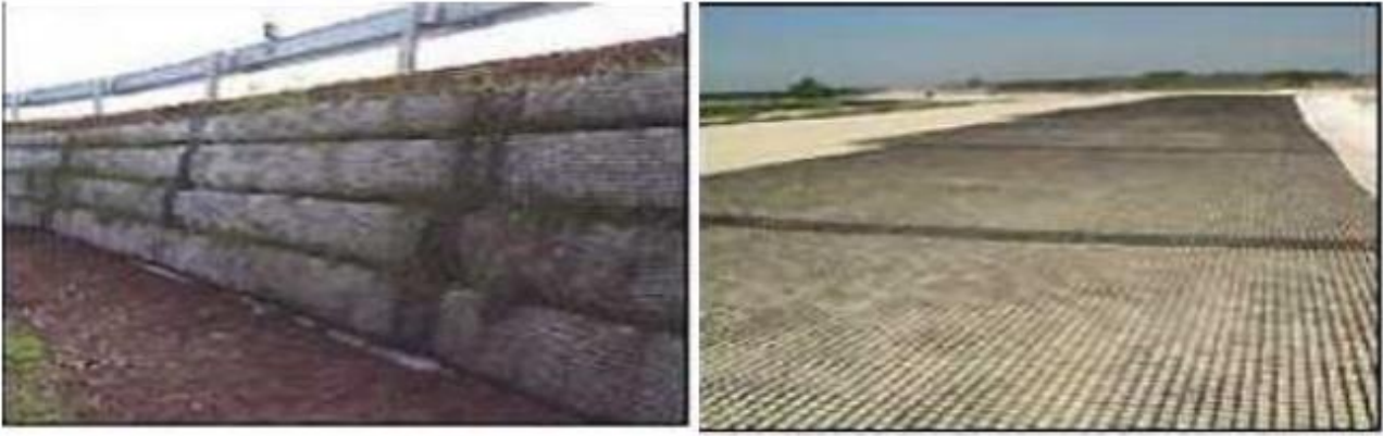
Figure 2.11: Renforcement par géo-synthétique
