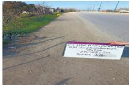
Accotement non revêtu PK 07+500
