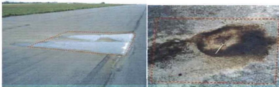
Figure 24 : Remontée d'eau
