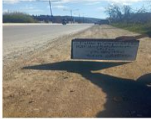
Dénivelé entre chaussée et accotement PK 06+100
