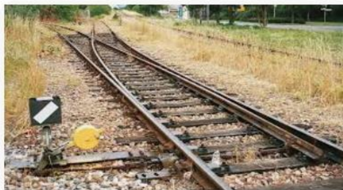
Figure 10 : La Voies ferrée
