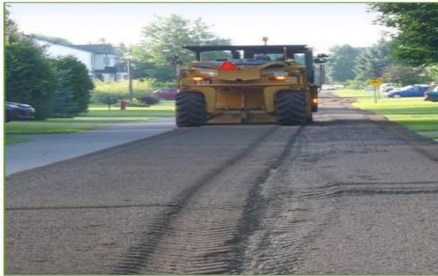
Figure 48 : chaussée décohesionnée.
