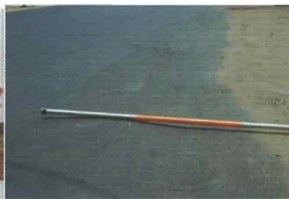
Figure 33 : Bourrelet mis en relief par la surélévation du jalon
