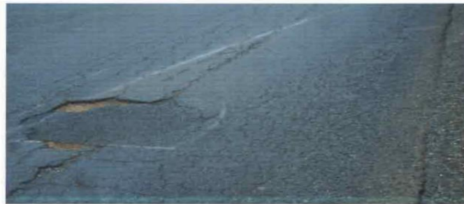
Figure 36 : Réseau de fissures longitudinales.
