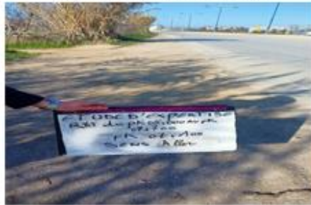
Accotement non protégé PK 07+100
