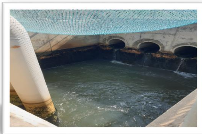
Figure III-1 : Photo du site de prélèvement du puits.
