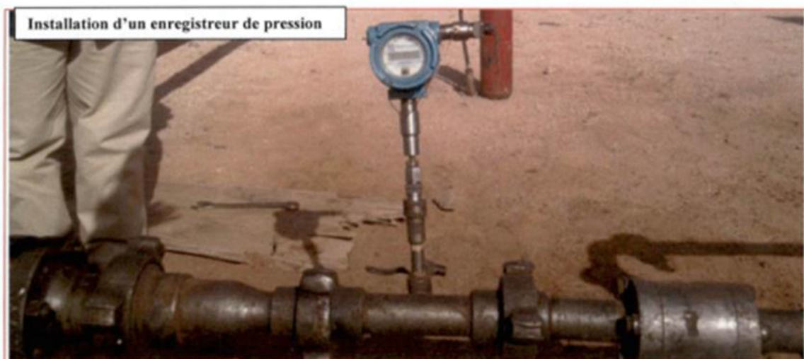
Figure (III-2) : installation d'un enregistreur de pression [22].
