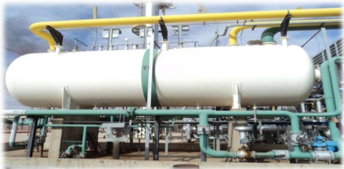
Figure (II -7) : Séparateur horizontal.
