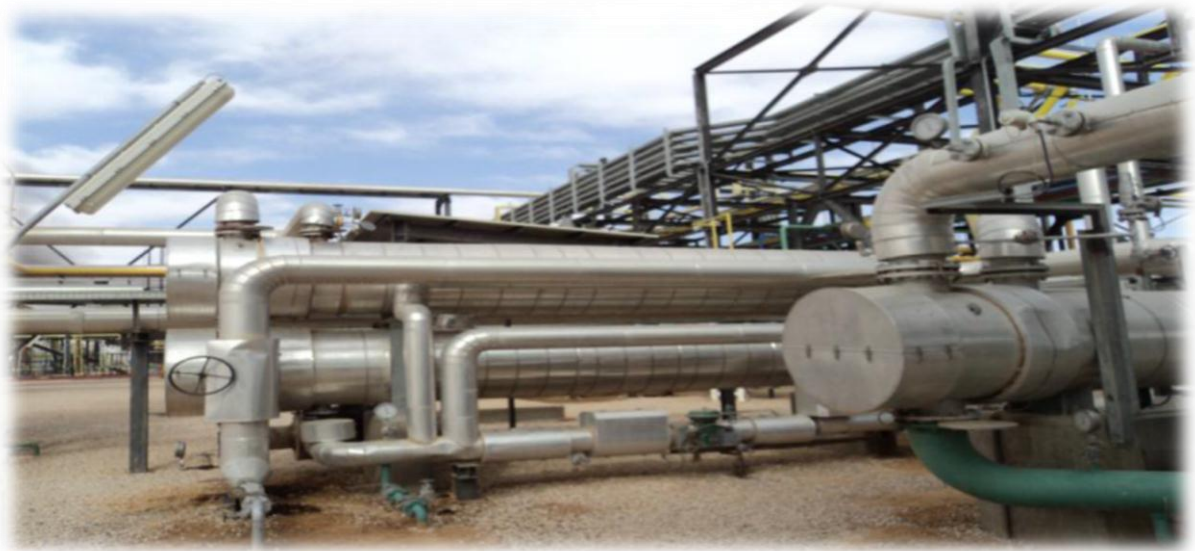
Figure (II-6) : Echangeur à vapeur.
