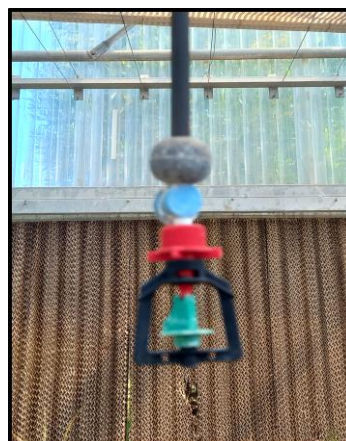
Photos 05, 06. Irrigation par brouillard (Photos personnelles, 2023).
