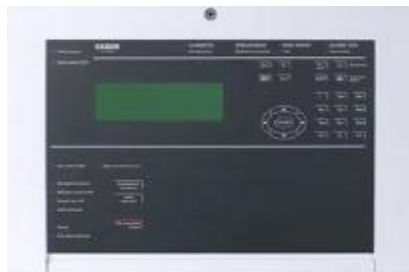
Fig. II.02. -Tableau de Signalisation SDI.
