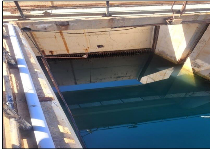
Figure 12 : Des grilles pour éliminer les macros particule
