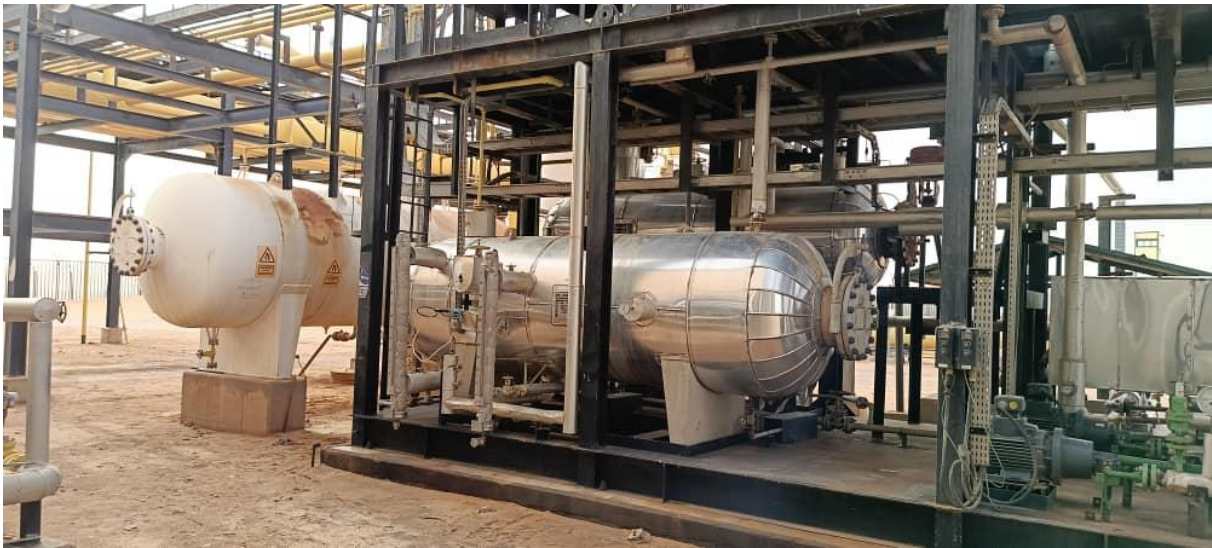
Figure 22- La section déshydratation par tri-éthylène-glycol 20-v-001 (Le 29-05-2024- à 10 :00AM)
