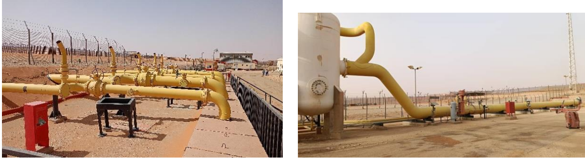
Figure 18-L'avenir du gaz (manifold et ballonne de séparation 20-B-001) (Le 29-05-2024- à 10 :00AM)
