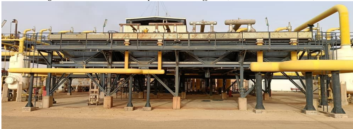
Figure20-La section de aéro-réfrigérants (Le 29-05-2024-à10 :00AM)
