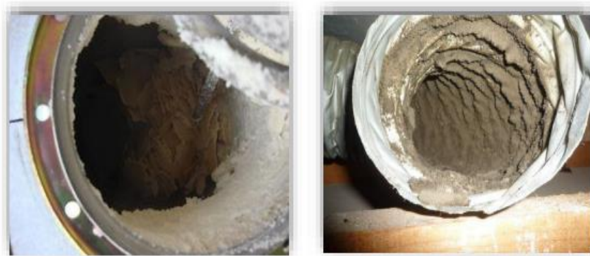
Figure II.22: Phénomène d'entartrage des tubes de chaudières.
