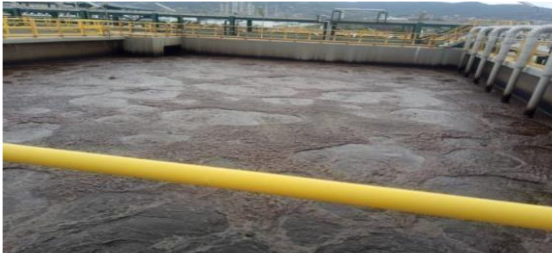
Figure. II .7. Bassin de traitement par boue active TN6.
