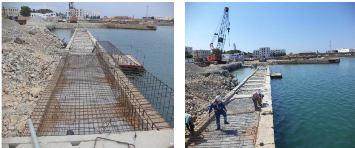
Figure VI.13. Ferrailage de la poutre de couronnement
