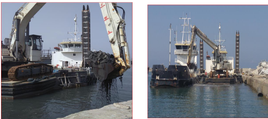
Figure VI.5. Dragage de souille.
