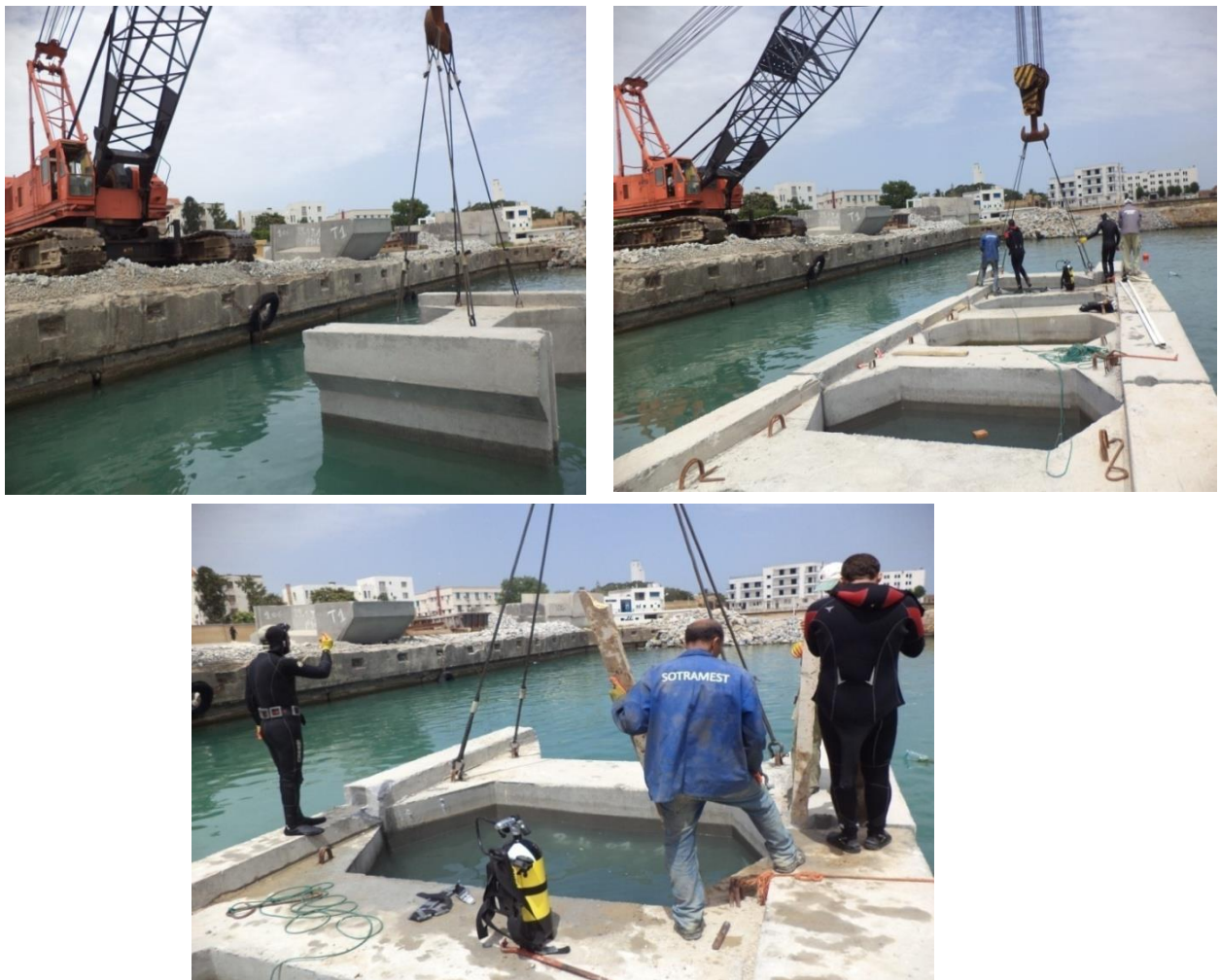
Figure VI.10. Pose des blocs de quai.
