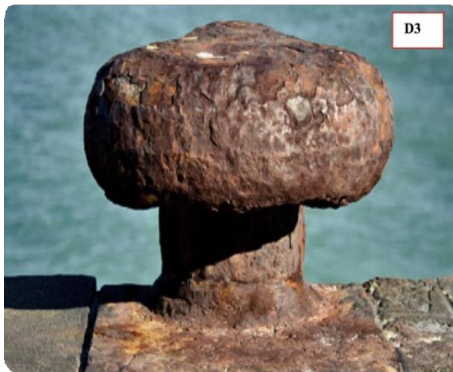
Figure II.4. Désordres des équipements (à gauche : Bollard et à droite : Défenses d'accostage).
