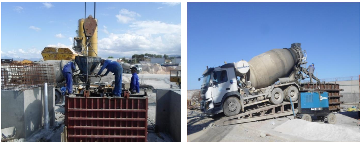
Figure VI.2. Bétonnage des blocs de quai.
