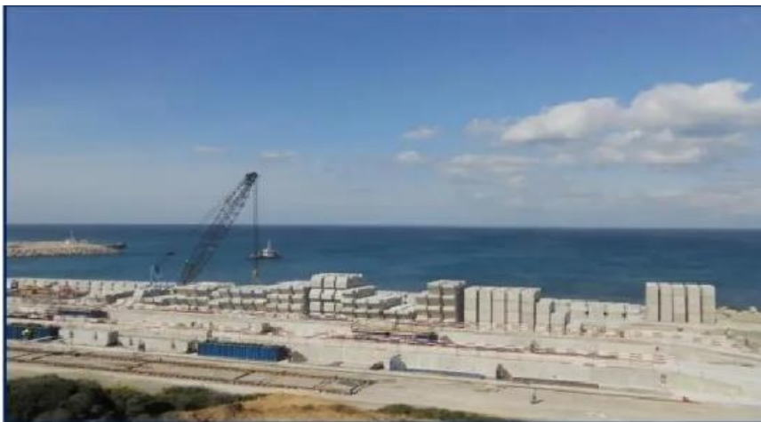
Figure VI.3. Zone de stockage des blocs de quai.
