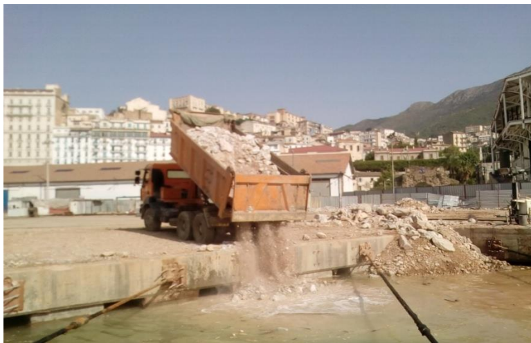
Figure VI.15. Mise en place de TVC (0-500) kg.
