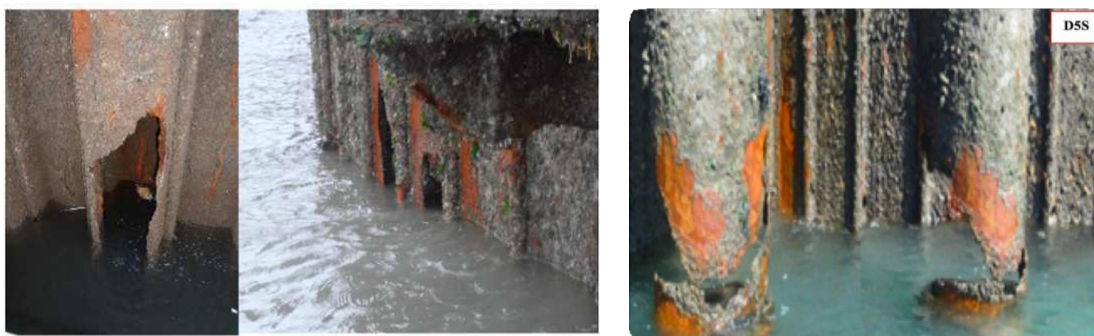
Figure II.18. Corrosion Perforante.
