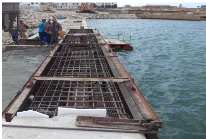
Figure VI.12. Coffrage de la poutre de couronnement.
