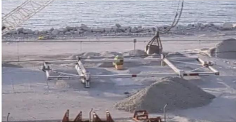
Figure VI.7. Cadre de réglage de l'assise des blocs de quai.
