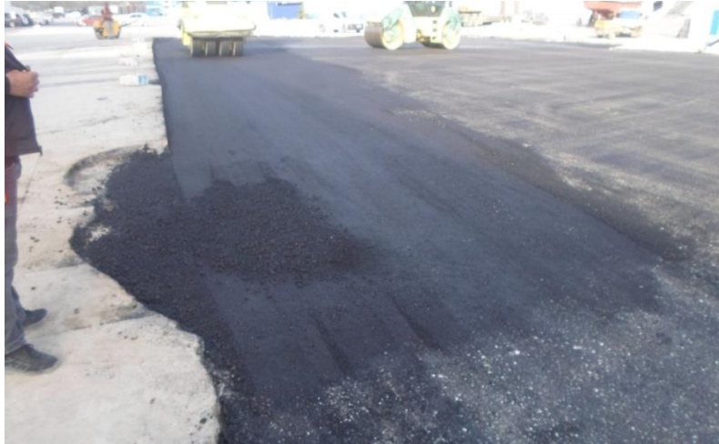
Figure VI.16. Mise en place de revêtement bitumineux.
