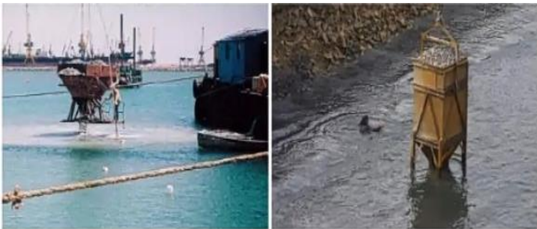
Figure VI.8. Mise en place du ballast de réglage de l'assise des blocs de quai.
