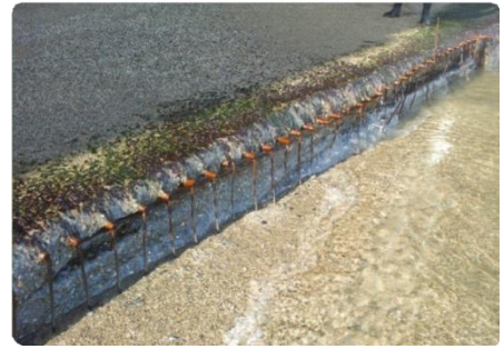
Figure II.13. Béton éclaté.
