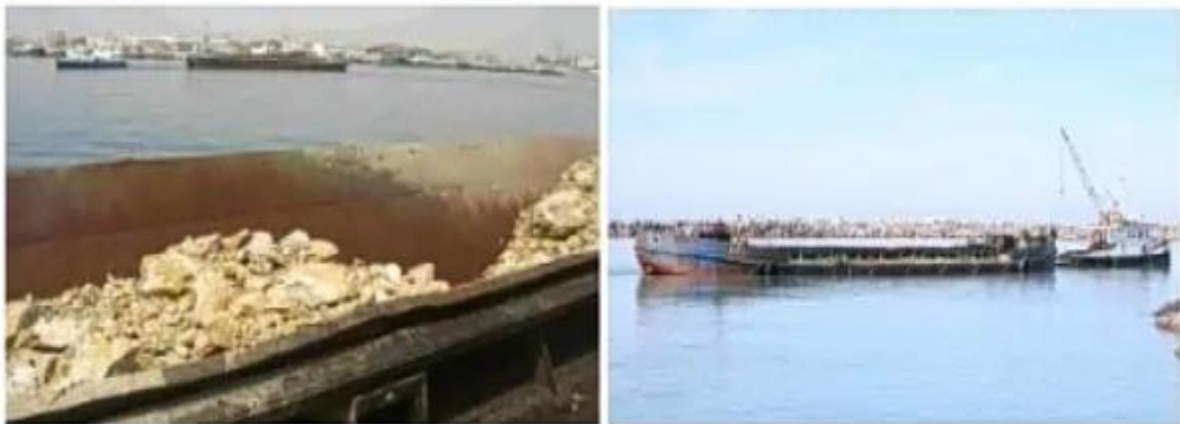
Figure VI.6. Chaland de mise en œuvre des enrochements de l'assise de fondation du quai.
