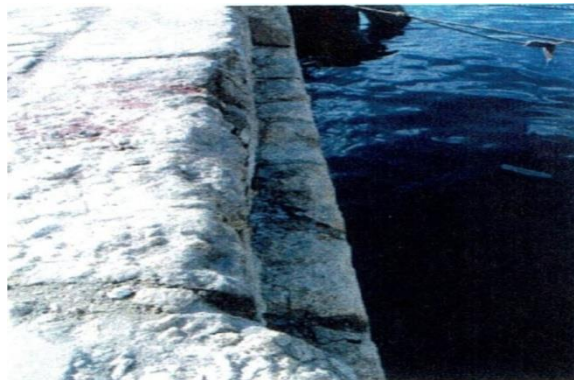
Figure IV.8. Couronnement endommagé.
