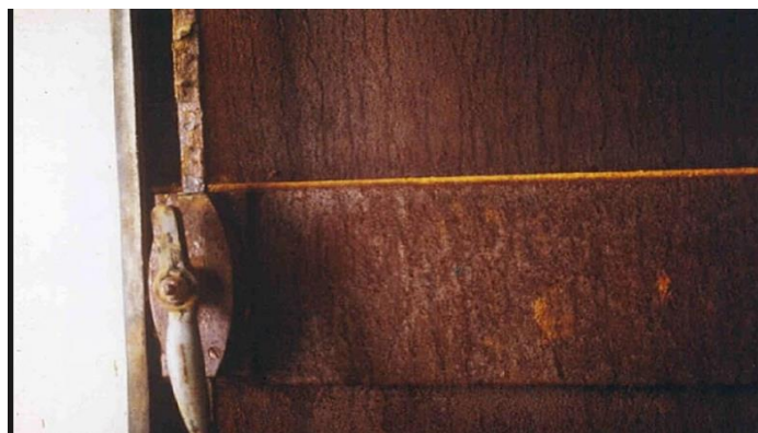
Figure I.5 : Corrosion générale (rouille) d'une pièce en acier [10].
