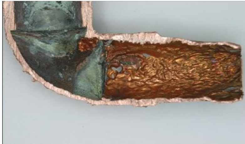
Figure. I.10: Attaque progressive par corrosion-érosion d'un métal recouvert d'un film de produits de corrosion : [15].
