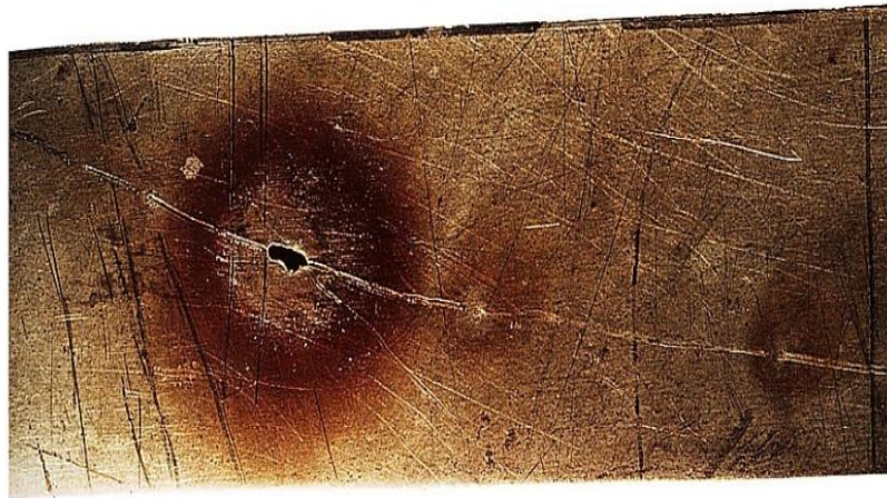
Figure. I.8: Corrosion par piqûres d'un acier inoxydable [9].
