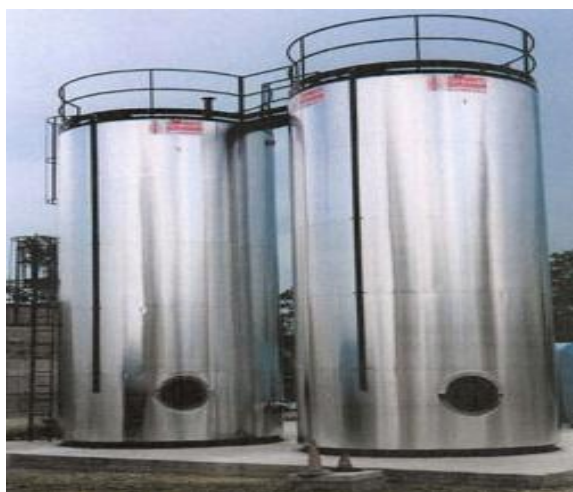
Figure III. 4– Réservoirs verticaux pour PMB [52].
