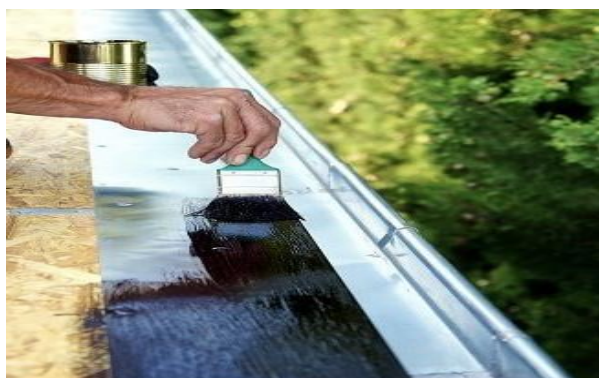
Figure III.5: Travailleur appliquant un BMP en revêtement imperméable à un toit [53].
