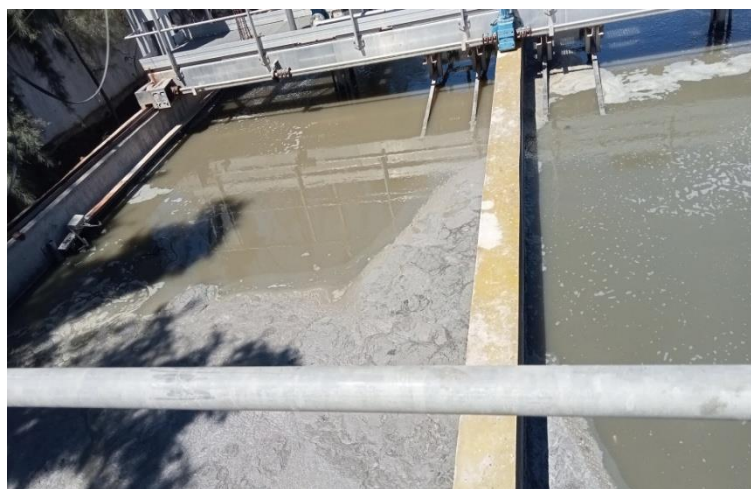
Fig. 04 : Dessablage – Déshuilage (Photo personnelle)
