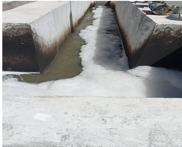
Fig. 03: Bassin de sortie
