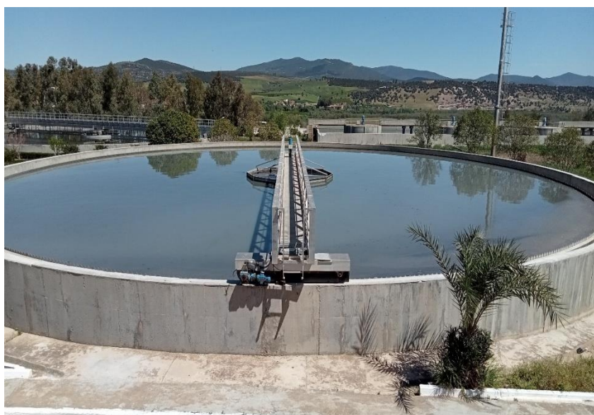
Fig.08: Clarificateur (Photo personnelle)
