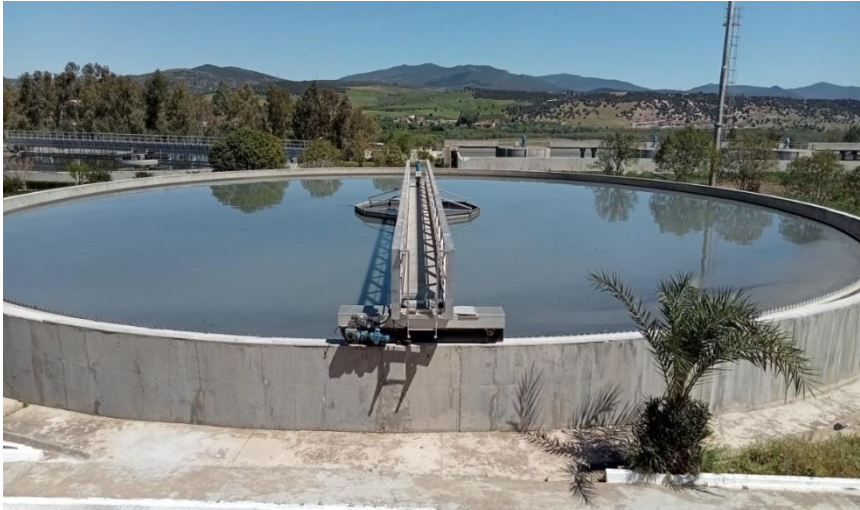
Fig. 05 : Décanteur primaire (Photo personnelle)
