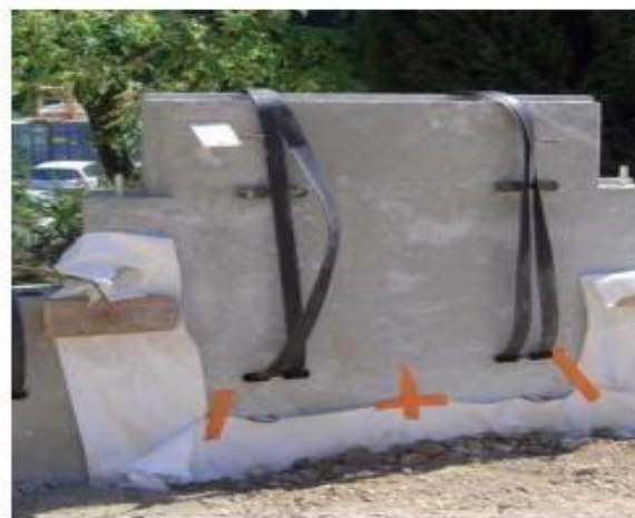
b. Renforcement avec le système de connexion GeoMega®
