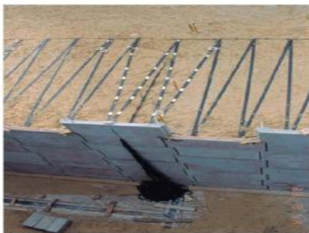
a. Renforcement avec le système Freyssisol®
